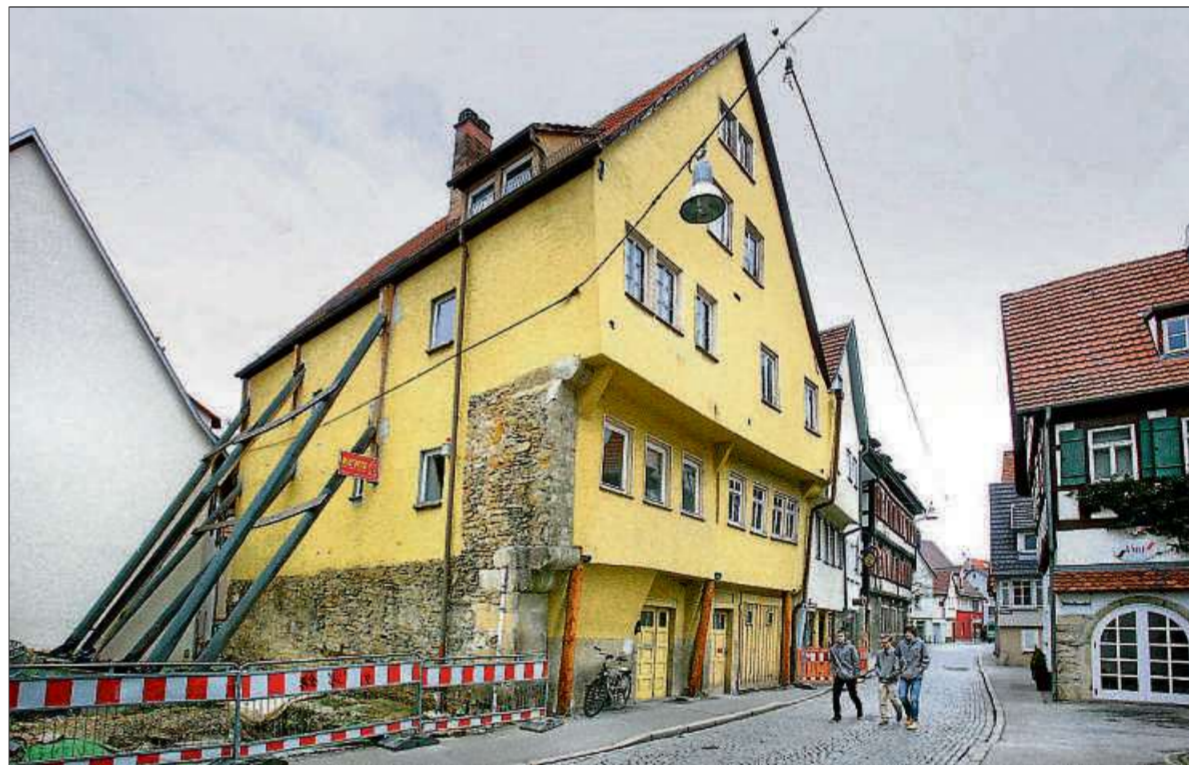
Eine der ältesten Häuserzeilen in Deutschland: Nachdem das Eckhaus in der Oberamteistraße 1972 abgerissen worden war, ist das um 1320 entstandene Ensemble in Schiefelage geraten und muss abgestützt werden. Archivbild: Haas
